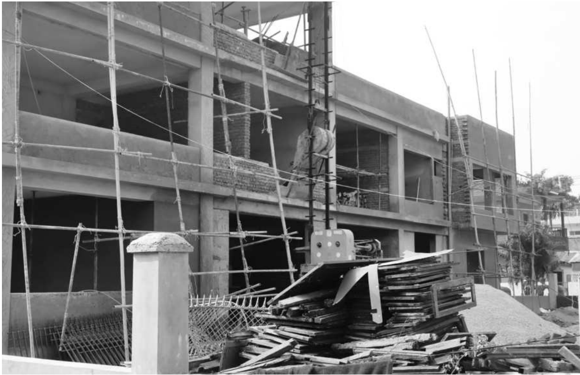
हेटौँडा-२ मा निर्माणाधीन आयुर्वेद तथा वैकल्पिक चिकित्सालयको भवन।
